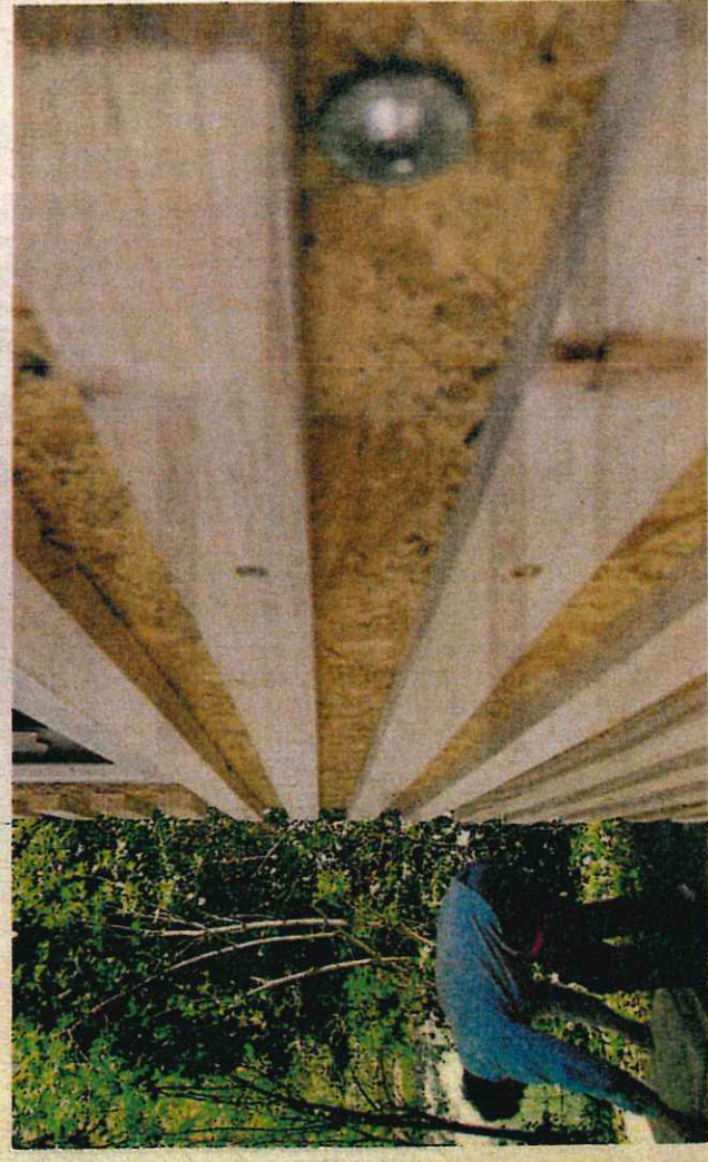
Waagrecht an dem „Little Home“ angebrachte Holzlatzen sollen verhindern, dass man durch die dünnen OSB-Paletten schlagen kann, aus dem das Häuschen besteht. Foto: Sebastian Reh
